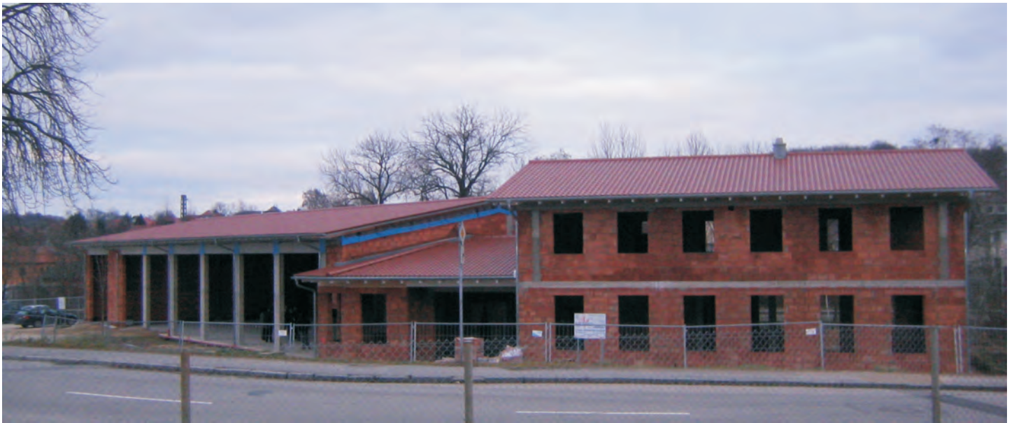
14.12.2007: Ansicht des Rohbaus zur Hebweihfeier
