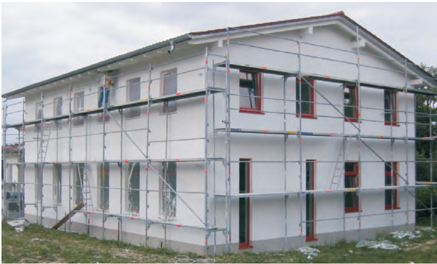
16.07.2008: Funktionsgebäude während der Außenputzarbeiten
