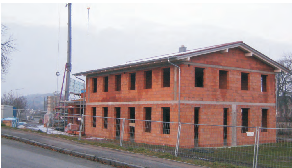
18.11.2007: Das Funktionsgebäude ist bereits eingedeckt
