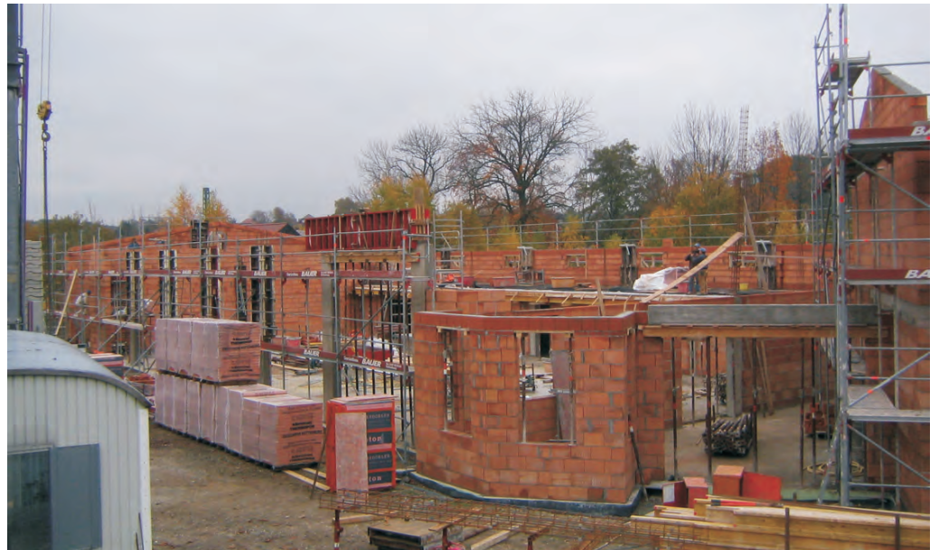
18.11.2007: Der Eingangs- und Hallenrakt entsteht
