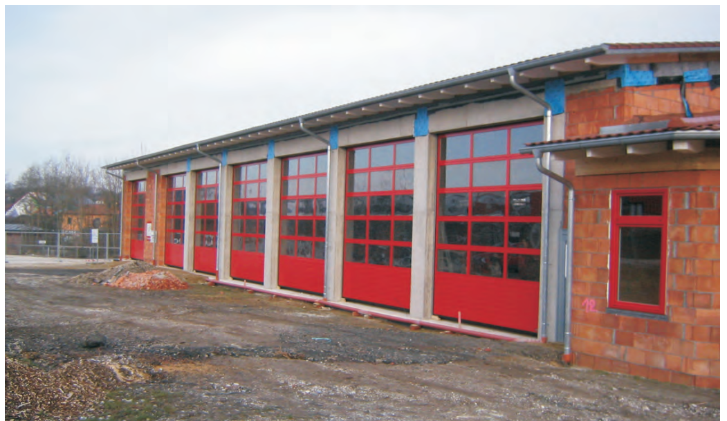
07.03.2008: Einbau der Deckensektionaltore
