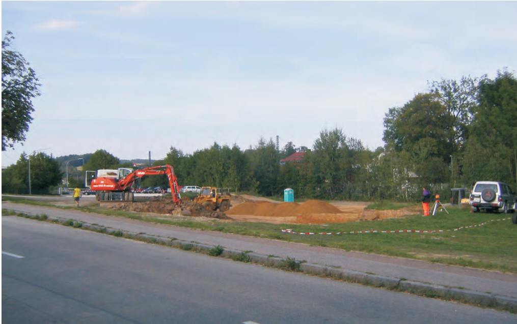
25.08.2007: Ausheben der Baugrube und Bodenaustausch
