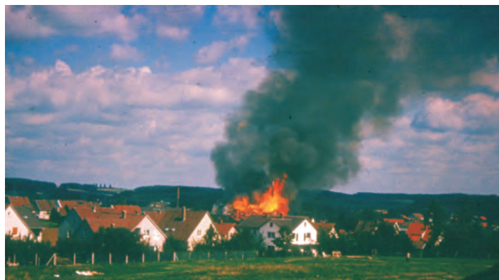
12.09.1968: Großbrand der Dachziegelwerke Ergoldsbach
