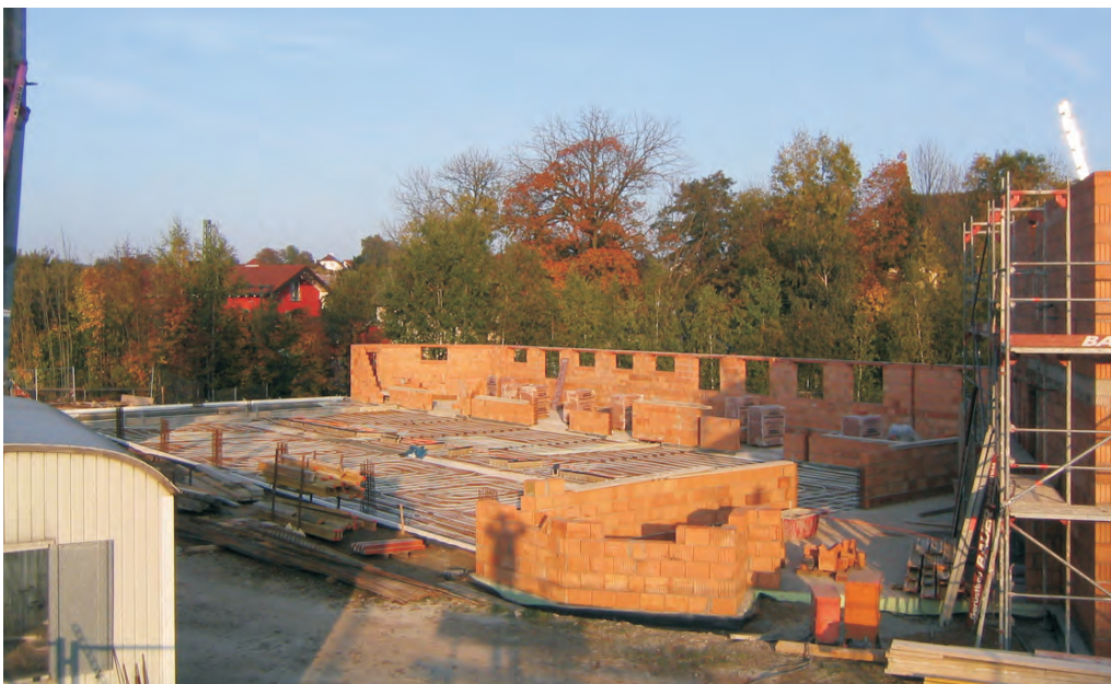
08.10.2007: Die Rohbauarbeiten schreiten voran
