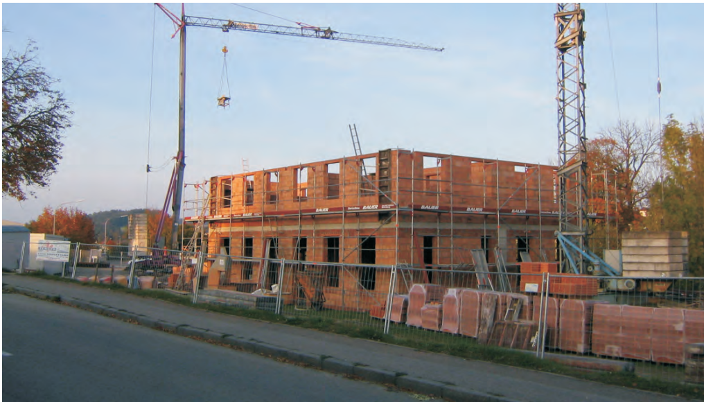
08.10.2007: Funktionsgebäude vor Einbau der zweiten Geschoßdecke
